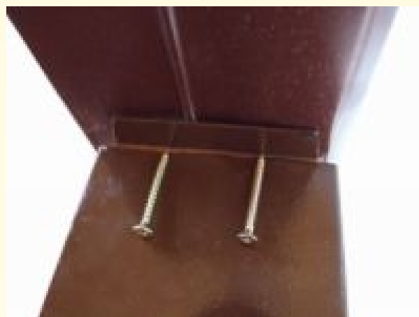
Montaż dolnej części poręczy do słupka
