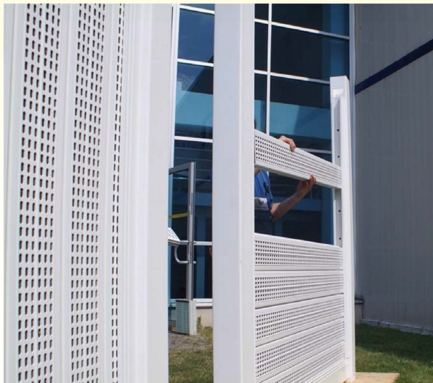
Rys. 5 Montaż paneli akustycznych jeden na drugim.
