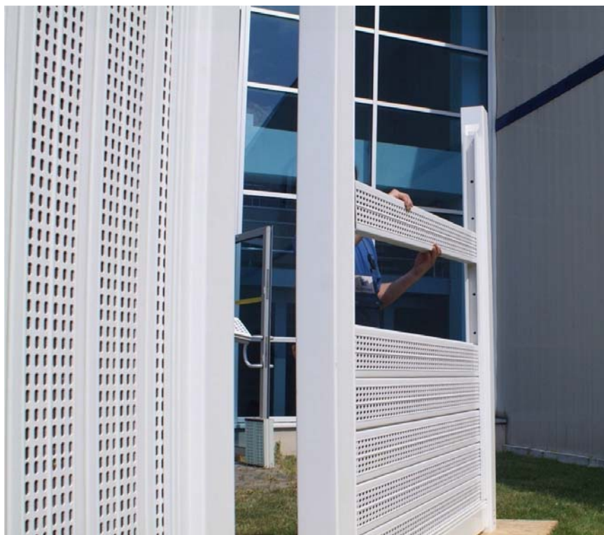
Rys. 5 Montaż paneli akustycznych jeden na drugim.
